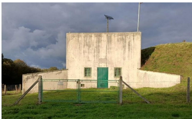
Réservoir de Mont
