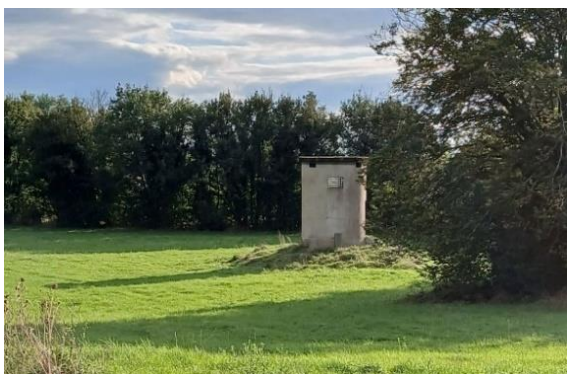
Un des puits de pompage de Perrigny-Sur-Loire
