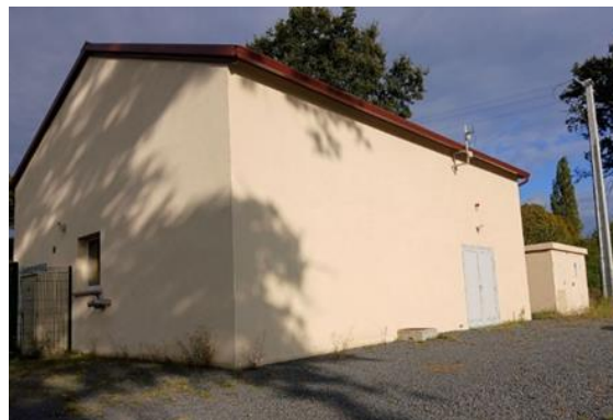
Station de production de Perrigny-Sur-Loire
