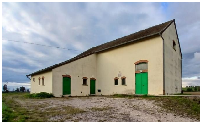
Station de production de Vitry-sur-Loire
